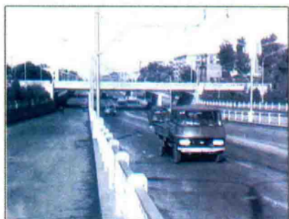
解放路地道桥旧貌
