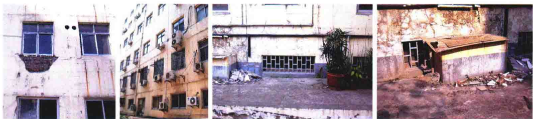
图 1-8 建筑外部细部原状
