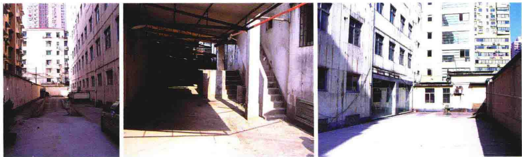
图 1-5 申都大厦建筑场地内部周边环境（建筑主体南侧、西侧、东侧）原状
