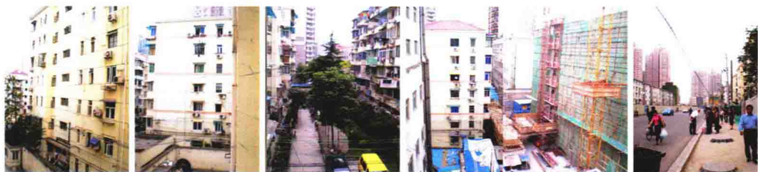
图 1-6 建筑场地外部环境原状
