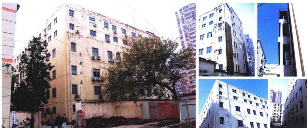
图 1-7 建筑外观原状
