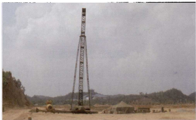
图 3.1—2 振动沉管施工现场
