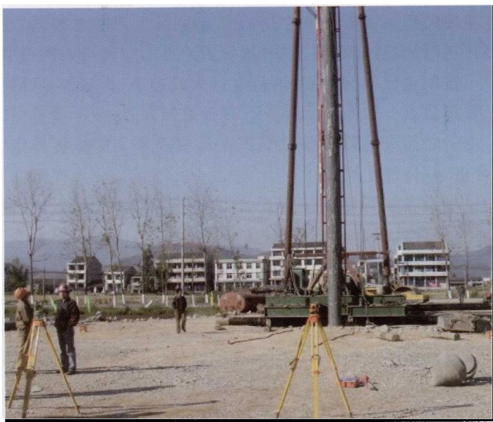
图 3.1—1 振动沉管施工
