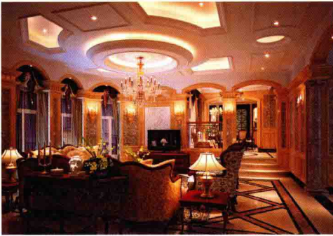
顶面 [ 石膏浮雕 + 石膏板造型暗藏灯带 ]
