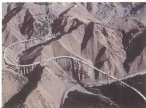
图 2-5 越岭段以桥隧相连为主的螺旋展线方案 卫星影像图
