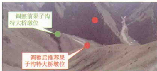
图 2-9 果子沟特大桥梁墩位
