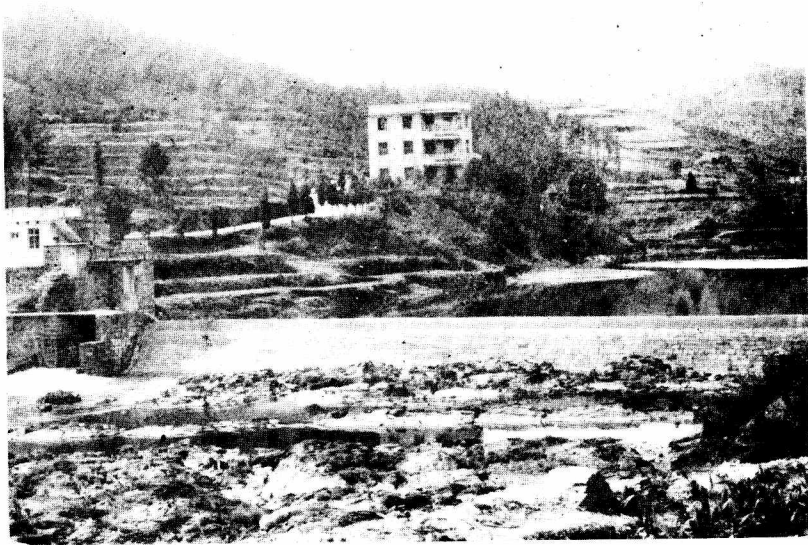
附廓水利 栏河坝
