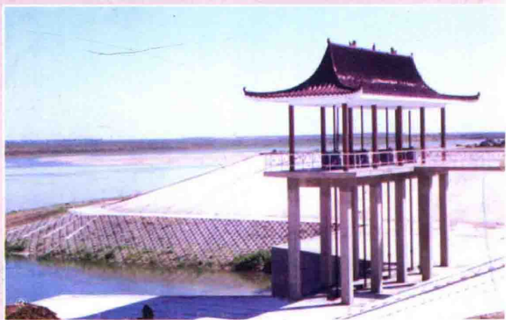
③新生电灌站进水涵闸
