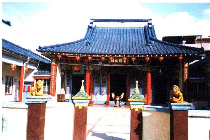
圖八 卓蘭鎮新榮里繼述堂詹屋祠堂
