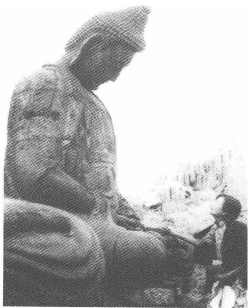
林徽因在山西汾阳县小相村灵岩寺 正殿东侧铁佛像前
