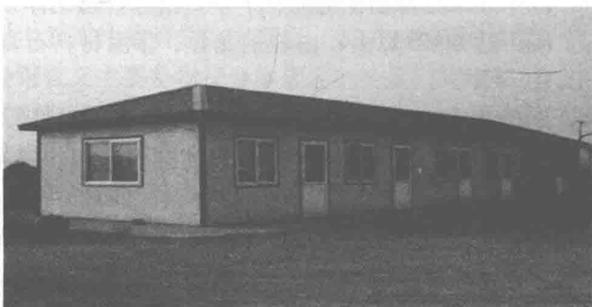
图 1.1.2 可拆卸的工棚
