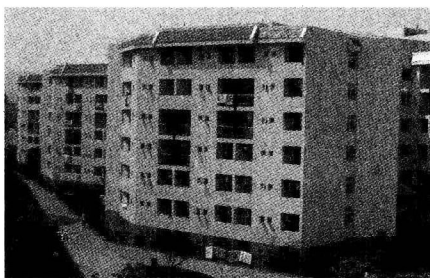
图 1.0-1 混凝土多孔砖砌体建筑
