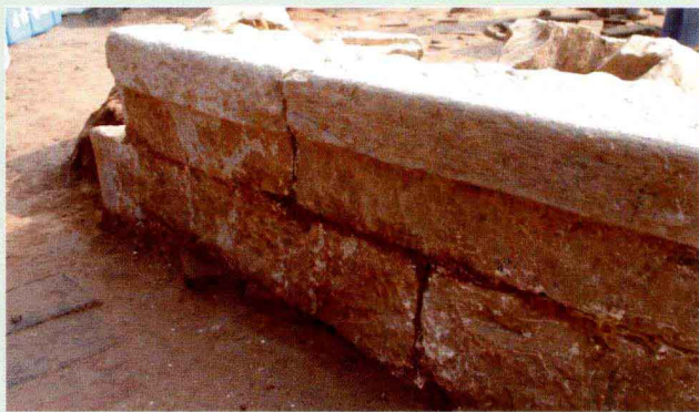
塔基青石基础局部
