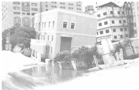
图 1-17 上海轨道交通 4 号线涌水事故
