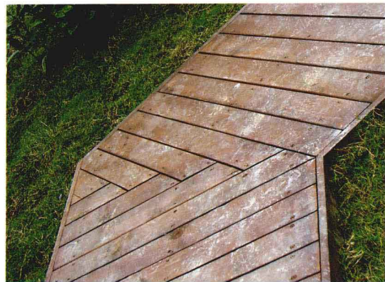
精湛的施工技艺
