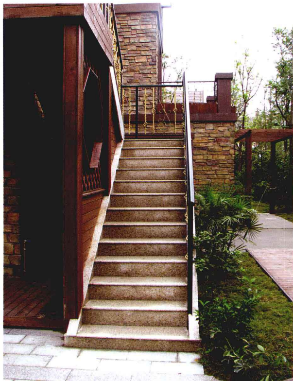
钢结构石材楼梯
