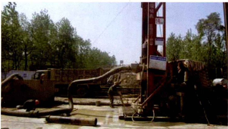
图 1.2—4 反循环钻孔施工
