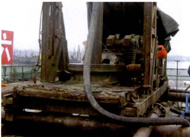
图 1.2—3 正循环钻孔施工
