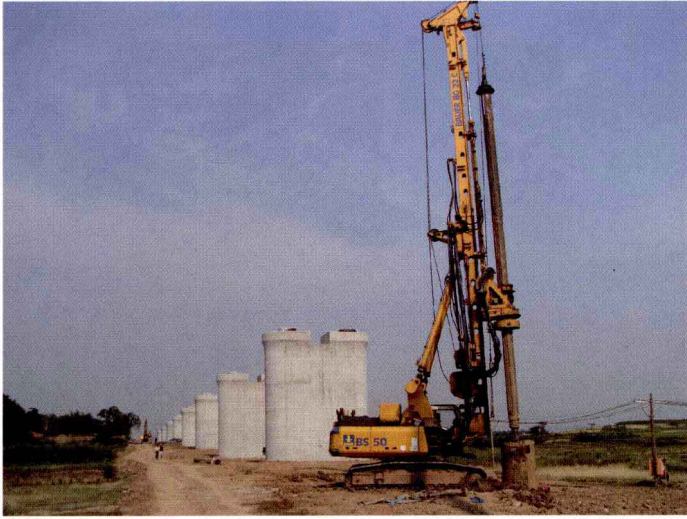
图 1.2—1 旋挖钻钻孔
