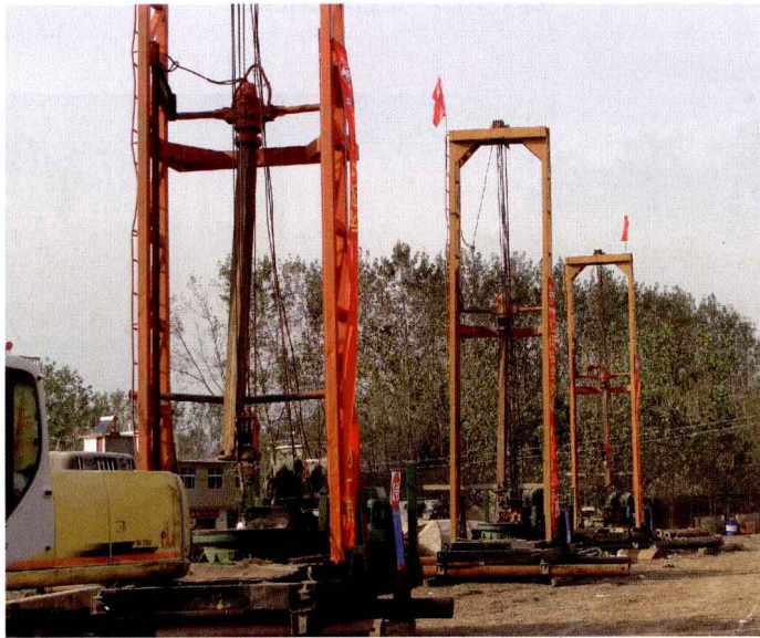
图 1.2—2 旋转钻机钻孔
