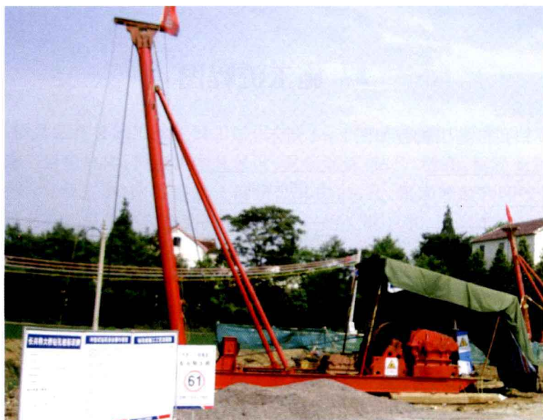
图 1.2—5 冲击钻钻孔
