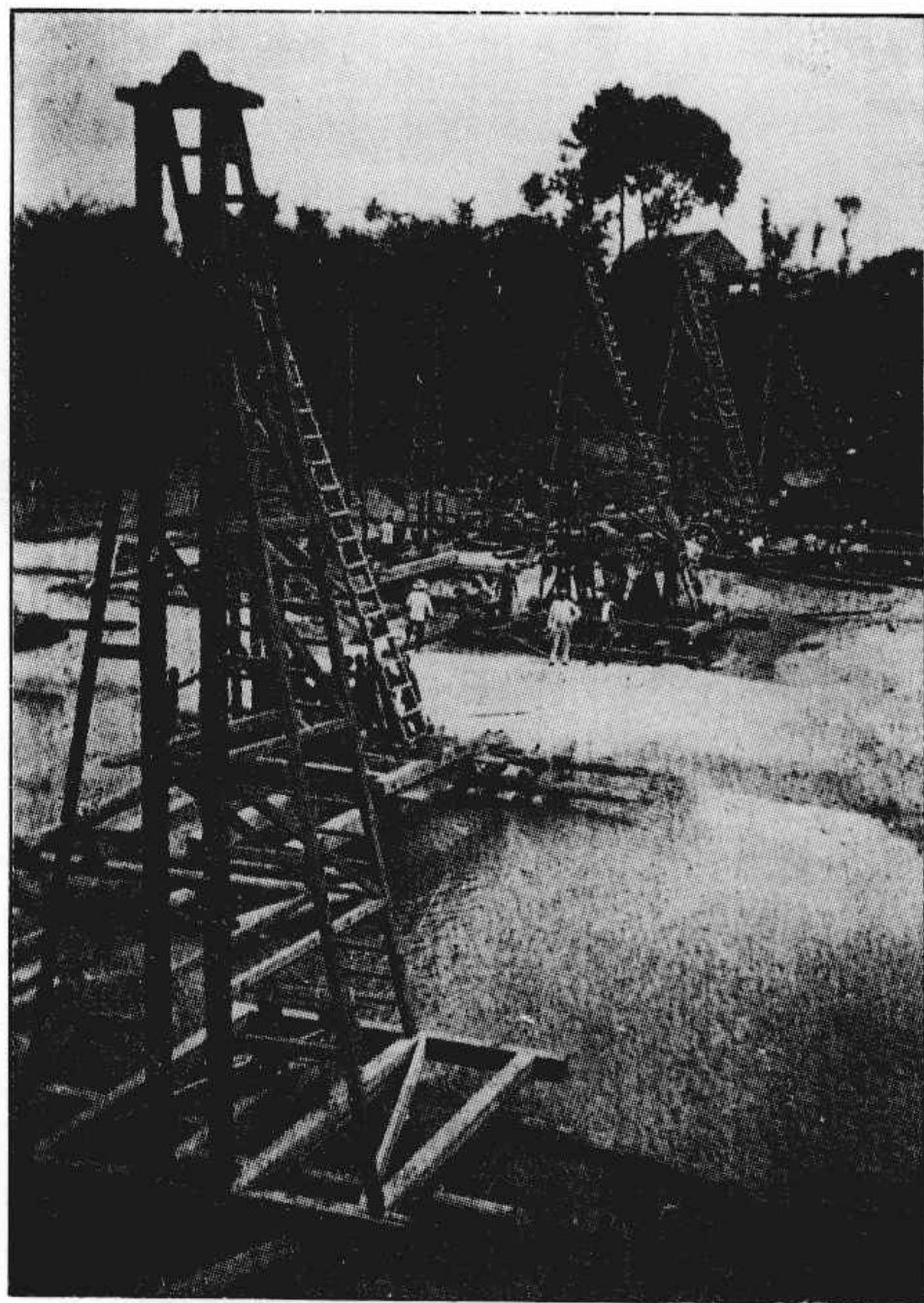
商办广东粤汉铁路桥梁施工情景。
