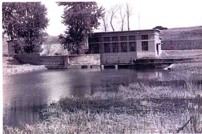
排涝泄洪功能完备
