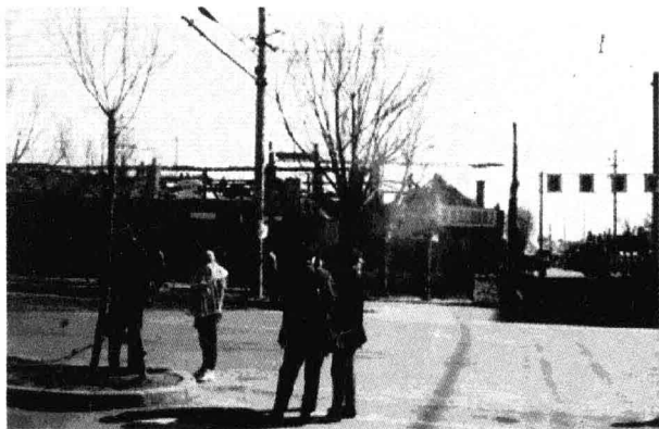
此房正在拆除,是吉林大马路的路南侧。回忆录中《日本鬼子快要投降那阵子》一文中所谈到的巷战就是从这里开始的……
