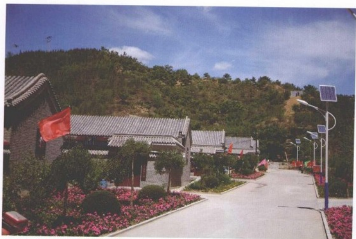
怀柔区八宝堂村太阳能路灯建设完工。
