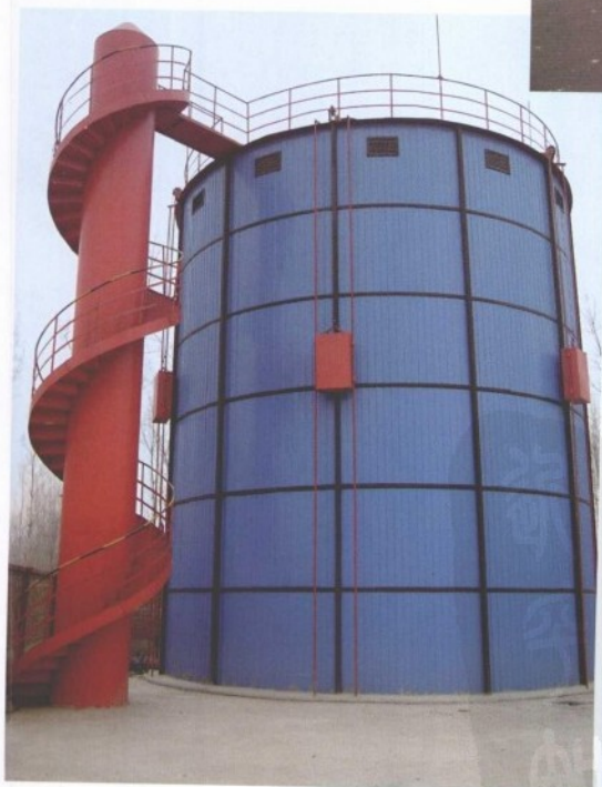
顺义区柴家林村沼气站。
