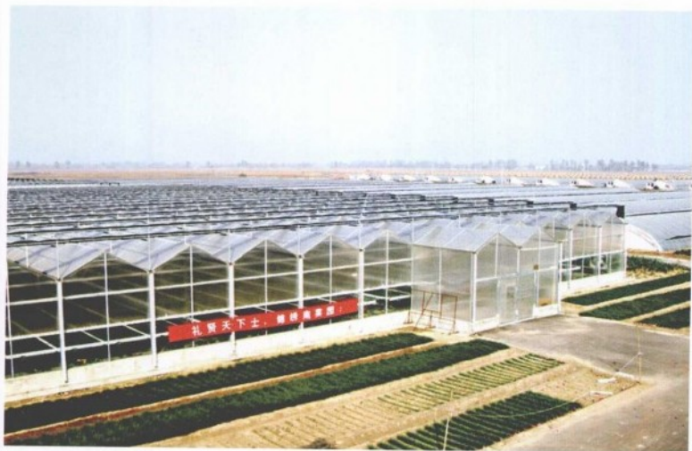
大兴区礼贤镇连栋温室。
