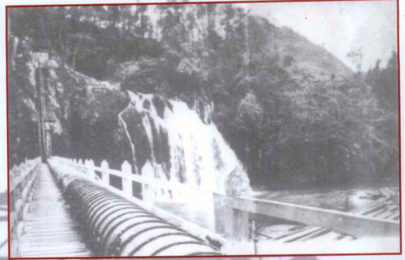
江口五里桥（白水洞）1956年建成的木质木桥倒虹管（上），1963年改建为双悬臂式钢筋混凝土桥及倒虹管（下）
