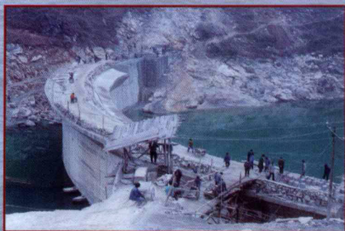
思南塘头鸡公滩电站大坝正浇筑混凝土
