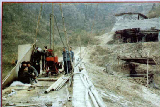
地区水电设计院地勘队正进行钻探
