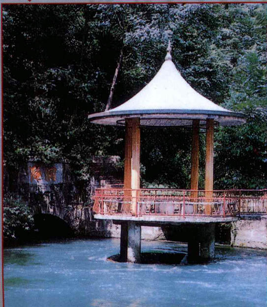
江口王家山电站前池竖井式溢洪道
