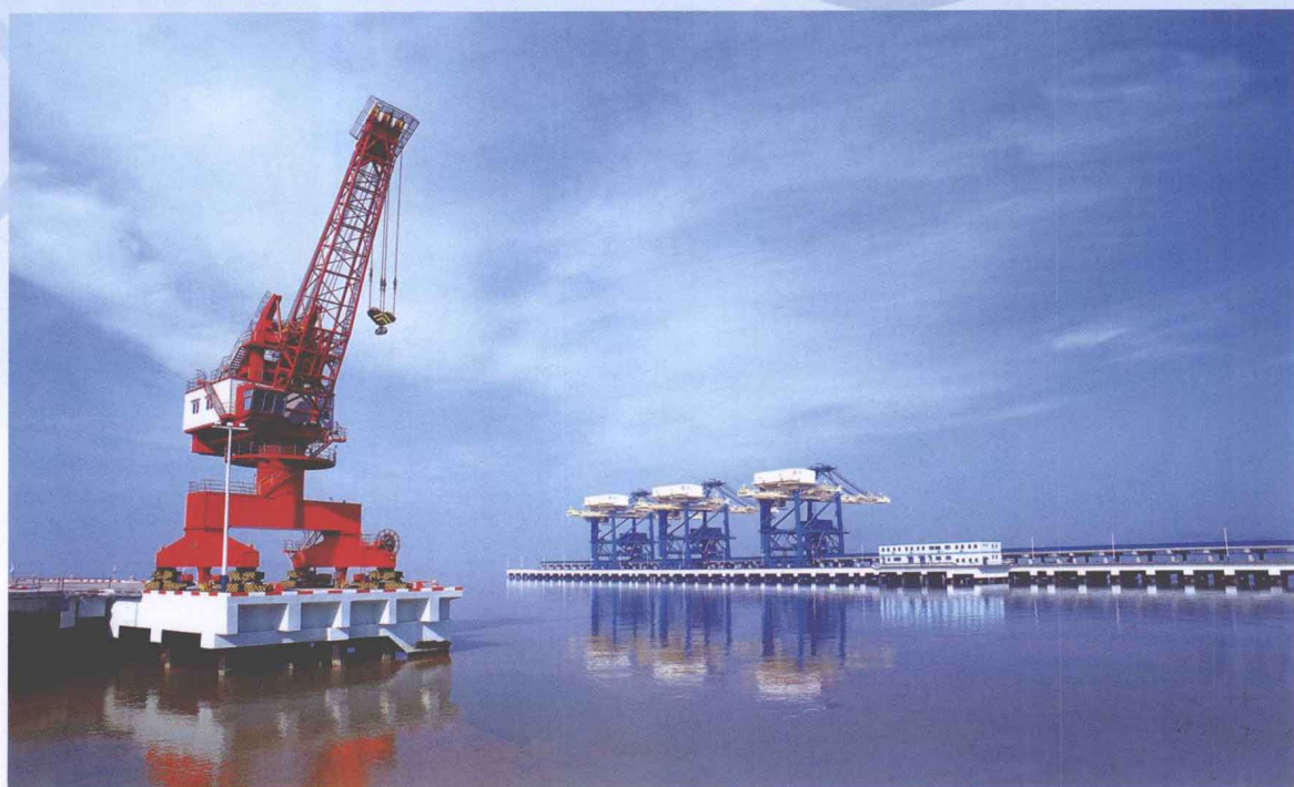
大唐乌沙山发电厂煤码头
