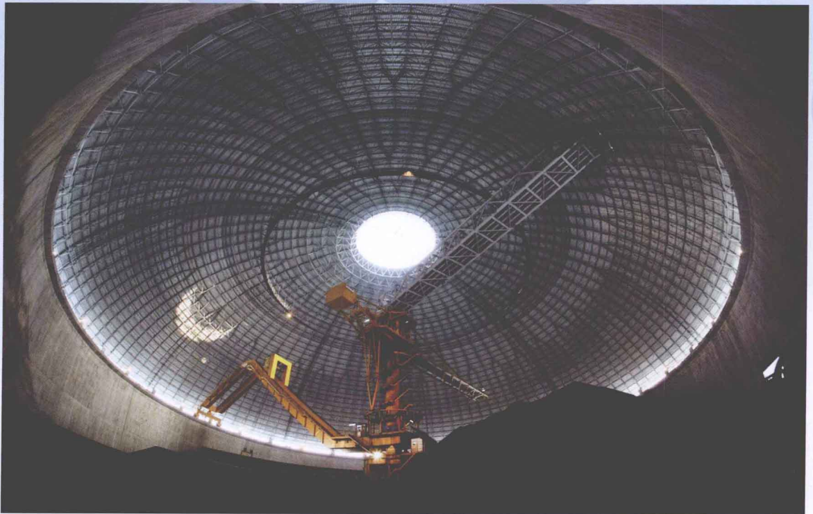
国华宁海发电厂可贮煤19万吨的全封闭煤罐，直径120米，为该厂环保措施之一
