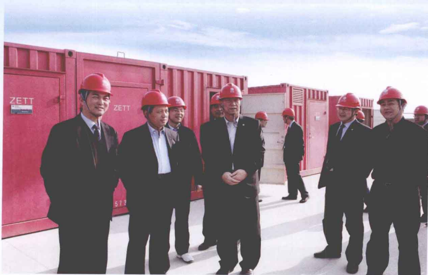
2009年2月1日，浙江省电力公司总经理赵义亮（左三）视察宁波电业局观城变电所
