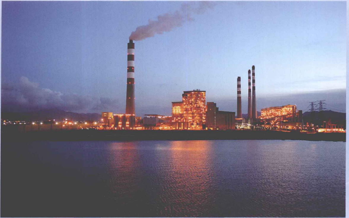
位于东海之滨的中国最大火力发电厂——装机总容量500万千瓦的北仑发电厂
