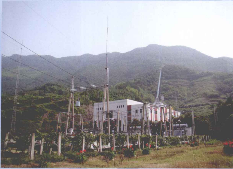
中国第一座中小型抽水蓄能工程——宁波溪口抽水蓄能电站
