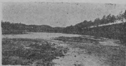
→11、治理后的均河河坝，坝高5米，面宽8米，图为刘家咀一段。
