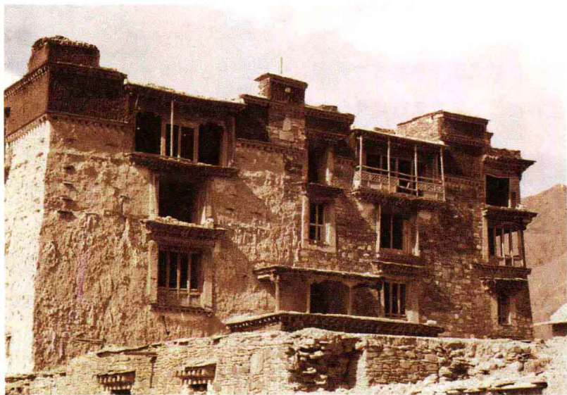
藏族碉房（清华大学建筑学院资料室供图）
