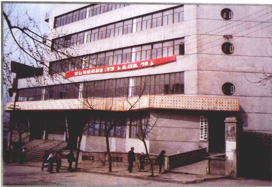
新建的六盘水市蔬菜 水产局办公大楼
