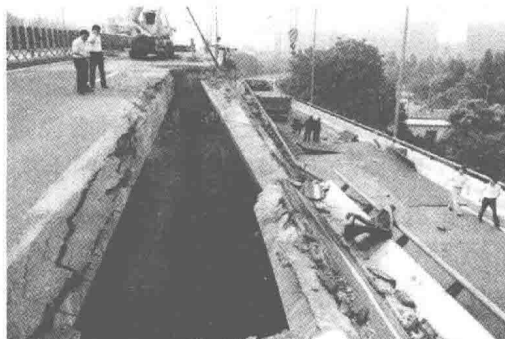
e) 浙江杭州钱江三桥辅桥
