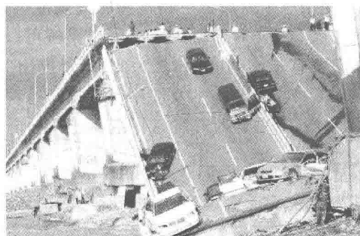
a) 台湾高屏大桥
