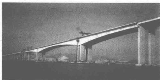
图1-2 虎门大桥辅航道桥
