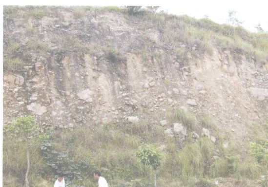
冒火山巴东组第三段破碎岩体深层风化
