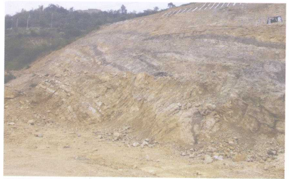
四道沟西侧巴东组第一段的倒转背斜
