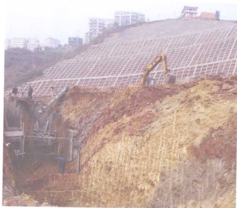
玉皇阁滑坡前缘治理施工揭露的滑带
