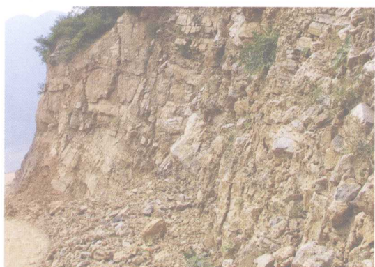
头道沟巴东组第三段破碎岩体
