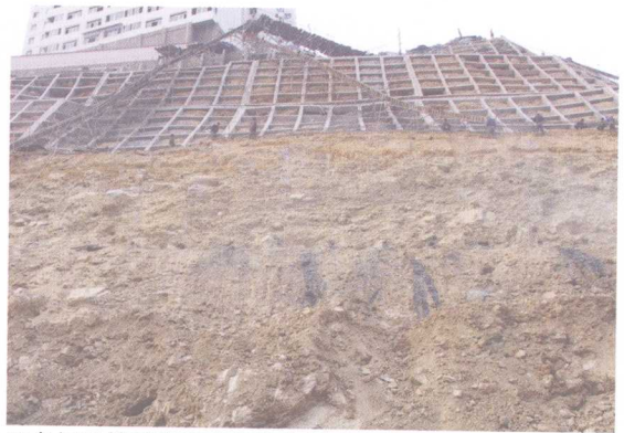
玉皇阁滑坡前缘破碎岩体的滑动构造
