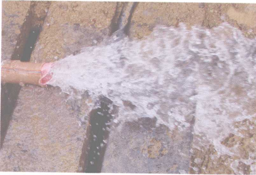
玉皇阁滑坡前缘施工揭露的地下水
