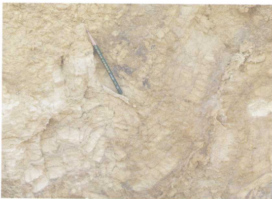
四道沟西巴东组第一段破碎岩体
