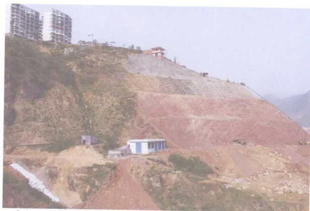
玉皇阁滑坡前缘地层异常接触关系及重力褶皱
