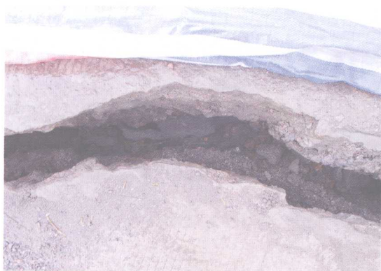
残联滑坡后缘变形裂缝
