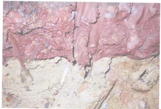
玉皇阁滑坡前缘施工开挖出的滑带
