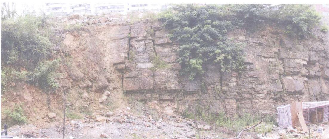
巫山县政府前巴东组第三段破碎岩体的松动裂缝及表层垮塌
