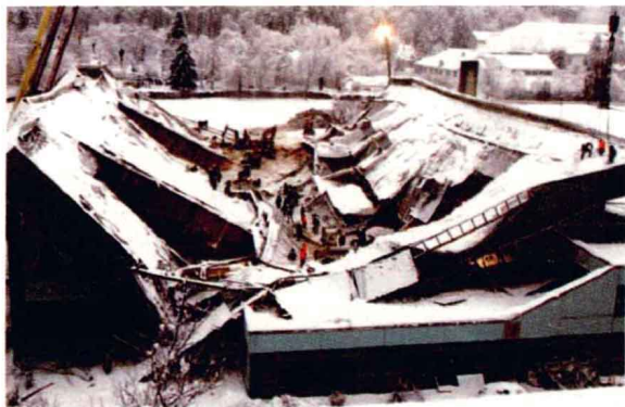
图1-6 某室内滑冰场的屋顶因结构强度不足以抵抗屋面荷载造成坍塌
