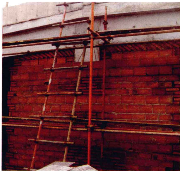
图1-17 某建筑物的砌体填充外墙
