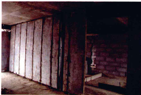
图1-19 某建筑物的轻质内隔墙
