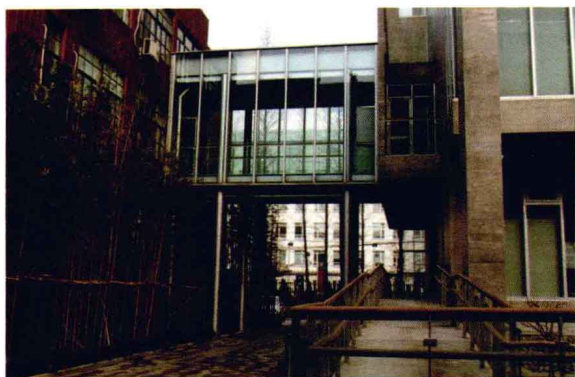
(a) 两栋相邻建筑间设有钢结构的过道
