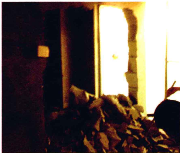
图1-15 拆除墙体前应判断是否承重墙
