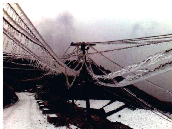
图1-13 因受力均匀仍处于平衡状态的电杆
