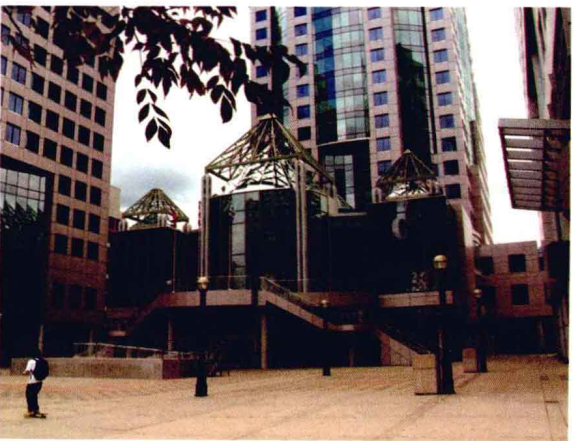
图1-4 钢骨架承重的某广场小建筑
