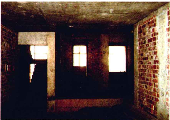
图1-3 砌体墙承重的住宅室内
