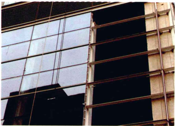
图1-18 某建筑物的玻璃幕墙
