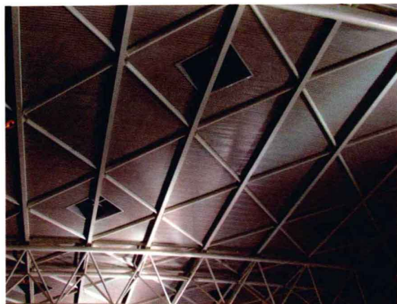
图1-11 水平结构系统需要加强刚度的实例
