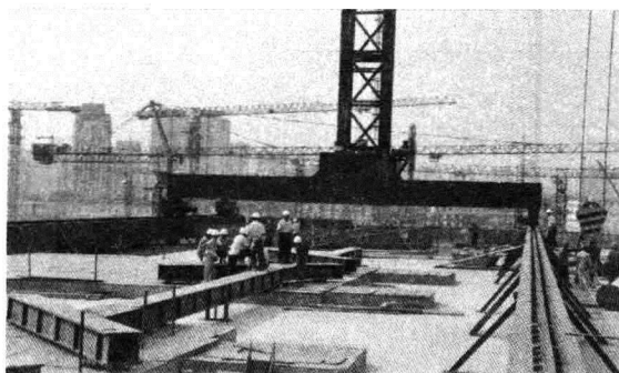
图5 21m跨 ZSL1100 行走式塔式起重机
