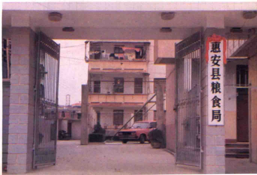
1989 年落成的惠安縣糧食局綜合樓
