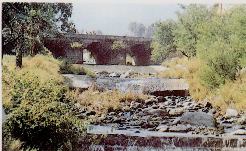
国道 214 线大理 观音堂 桥
