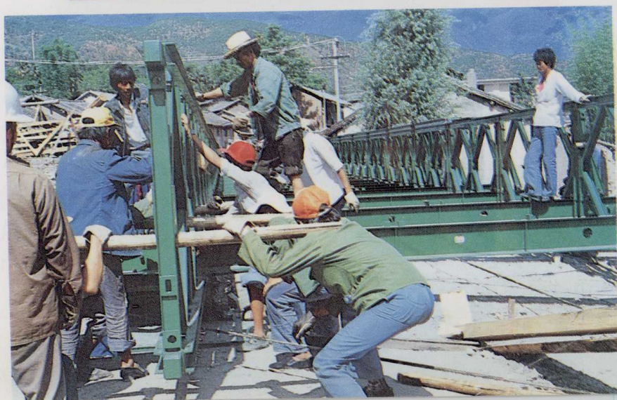
养路 工人架 桥忙
