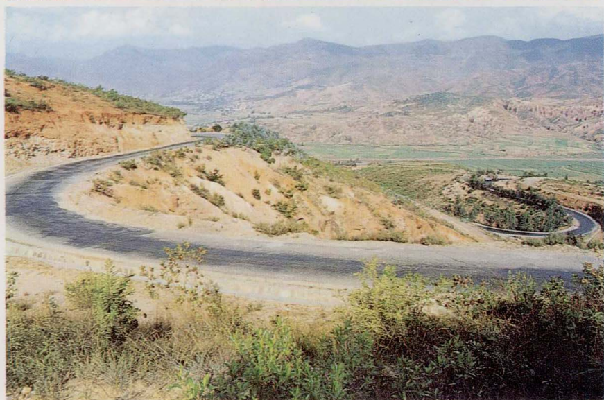
国道 214线 K2465 盘山公路 南漫湾 一漫电站
