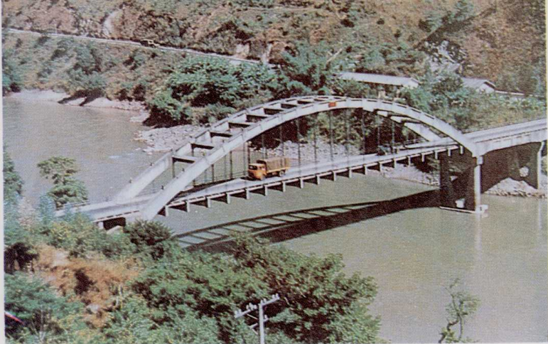
国道 320 线永保 桥
