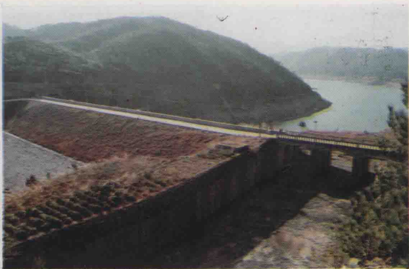
陈田水库坝区
