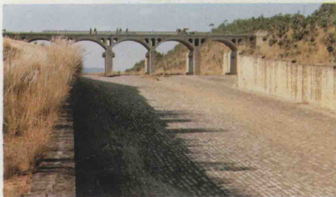
乌潭水库溢洪道
