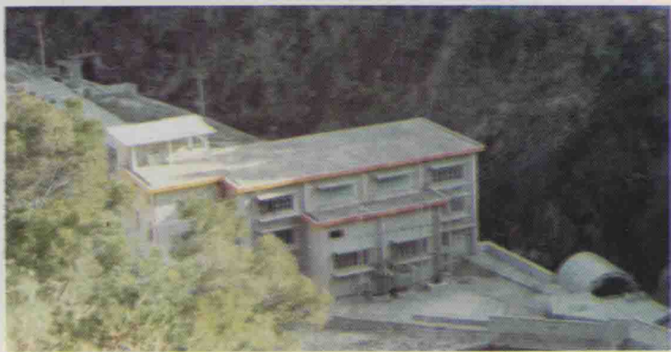
陈田水库坝后『一级电站』
