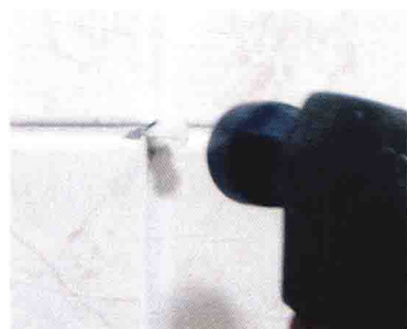
04 洞钻好了，将壁虎（壁虎膨胀螺丝）钉入洞中。
