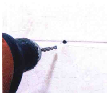
03 将电钻调到震动模式，换上专门钻墙壁的钻头，在记号的位置钻洞。
