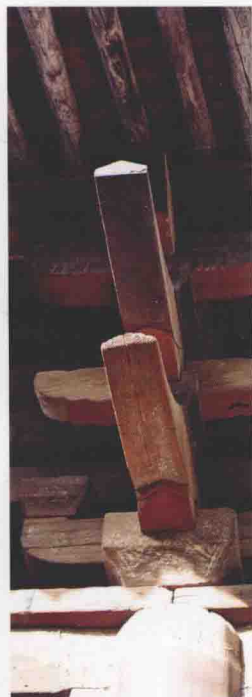
晋祠献殿柱头铺作
