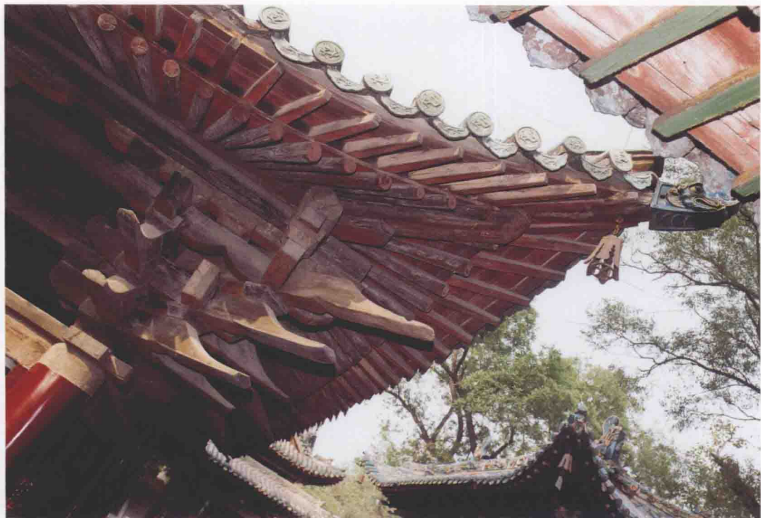
晋祠献殿转角铺作
