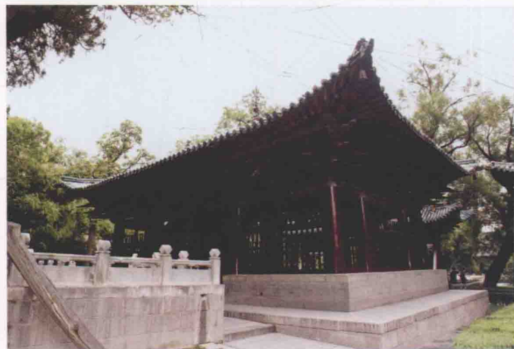
晋祠献殿东北立面
