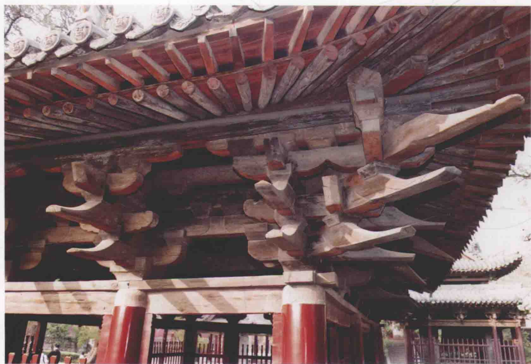
晋祠献殿转角铺作
