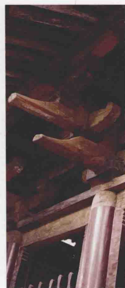
晋祠献殿柱头铺作
