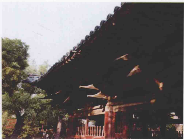
晋祠献殿后檐铺作
