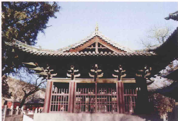
晋祠献殿南立面
