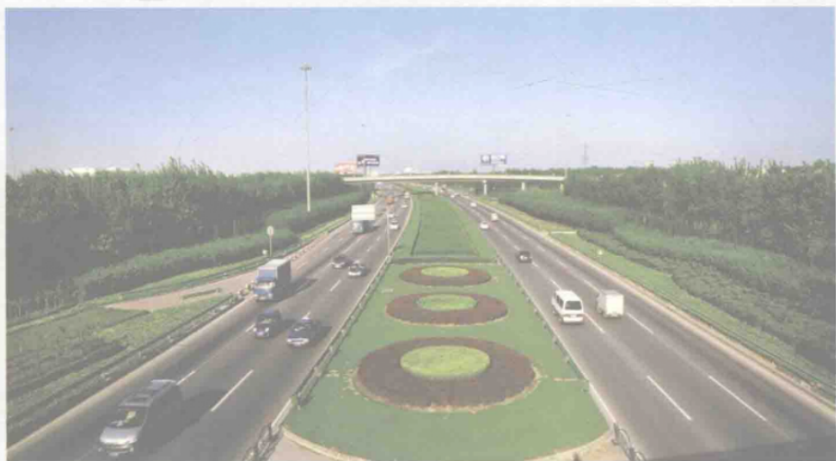
2008年4月浦东罗山路延长线工程
