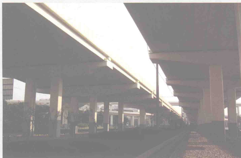
2009年10月涂装后的外环高速公路沪青平立交
