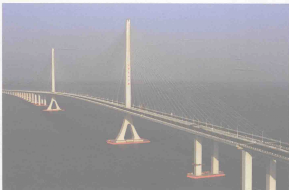
2011年10月31日上海长江隧桥建成通车
