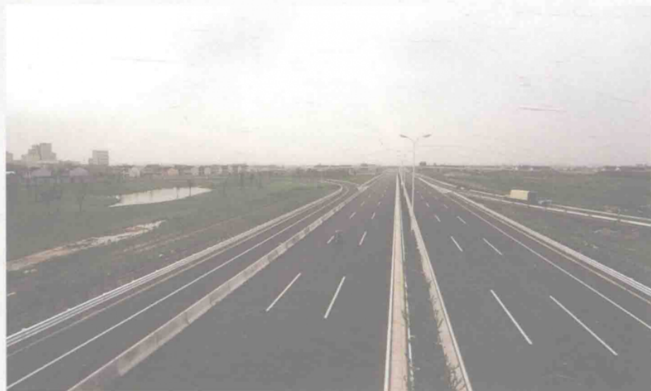
2011年6月30日林海公路建设工程竣工
