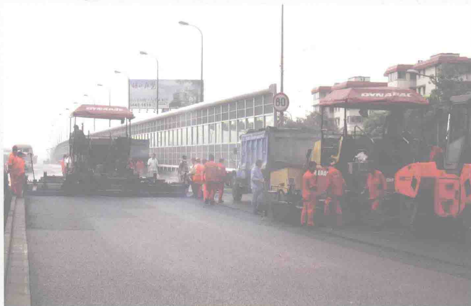
2008年3月外环高速公路路面大修沥青混凝土摊铺
