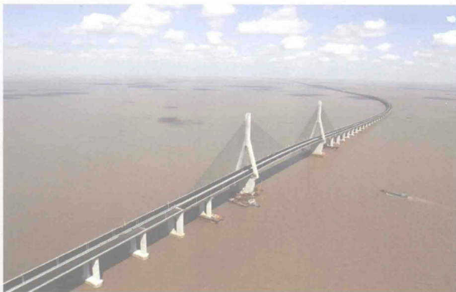
2005年12月东海大桥建成通车
