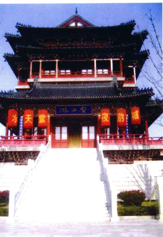
江苏泰州望海楼
