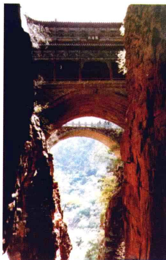
河北井陉桥楼殿
