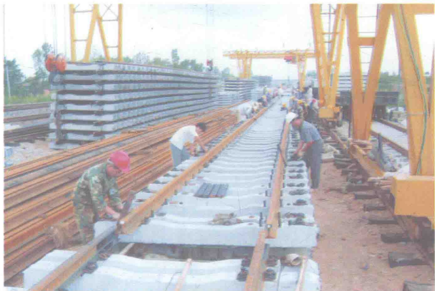
中铁十九局承担铺架项目工程
