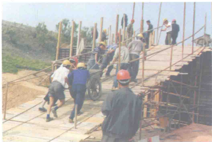
在无机械设备的情况下，工人们就是这样一车车将混凝土拉上陡坡。
