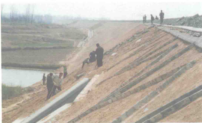
中铁十九局 采用 V 形式护 坡。
