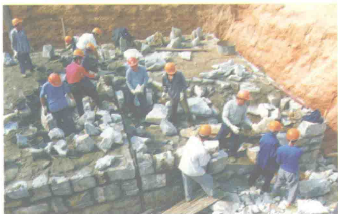
确保桥涵基础工程质量。
