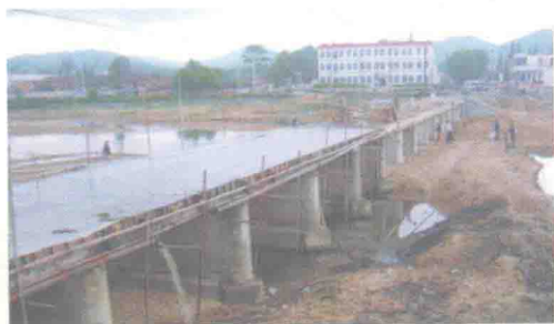
北京铁路局援建水毁后的草店镇游河公路桥
