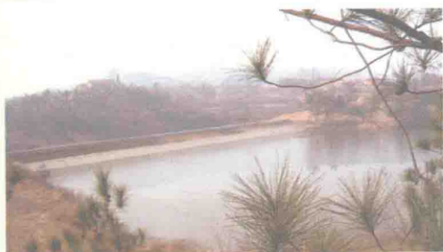
路方为地方修建的新堰
