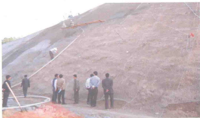
中铁十七局 采取挂网喷射混 凝土防护路堑边 坡。
