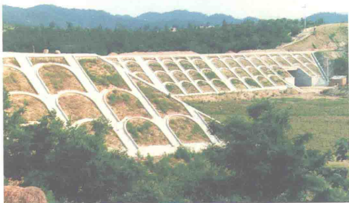
北京铁路局 路段的护坡工程。
