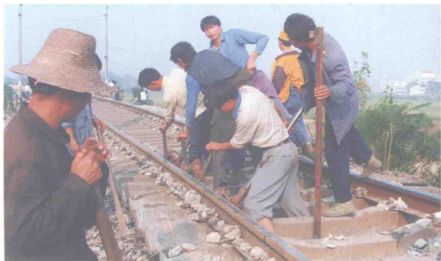
2002 年 12 月 27 日, 中铁十九局完成联络线铺架工程。
