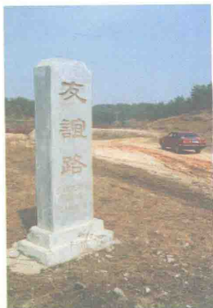
沈铁集团机械公司和 中铁十九局第一项目部共 同将高城至卸家乡村小道 扩建成二级公路。
