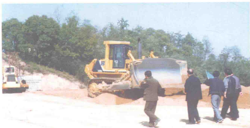
为加快工程进度, 中铁十七局新购置价值 300 余万元的堆土机用于施工。
