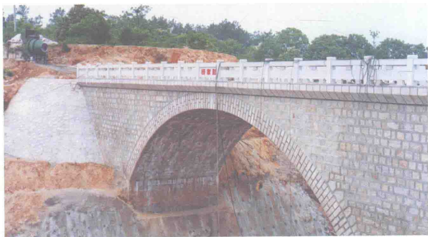
中铁十七局投资 40 万元援建小林新寨村拱跨铁路桥
