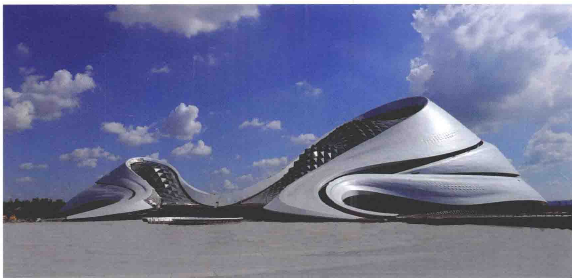
图 C-4 哈尔滨大剧院双曲面清水混凝土 GRC 板与铝幕墙相映成辉 (沈阳兆寰)
