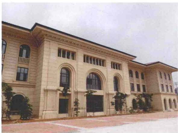
图 C-7 旅顺现代化高中 GRC 外墙 (大连泰和)
