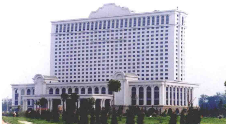
图 C-3 洛阳中亚大饭店 GRC 建筑装饰构件 (大连山泰)
