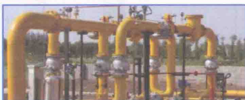
1K415000 城市管道工程
