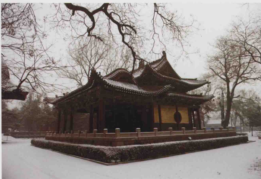
晋祠水镜台侧立面
