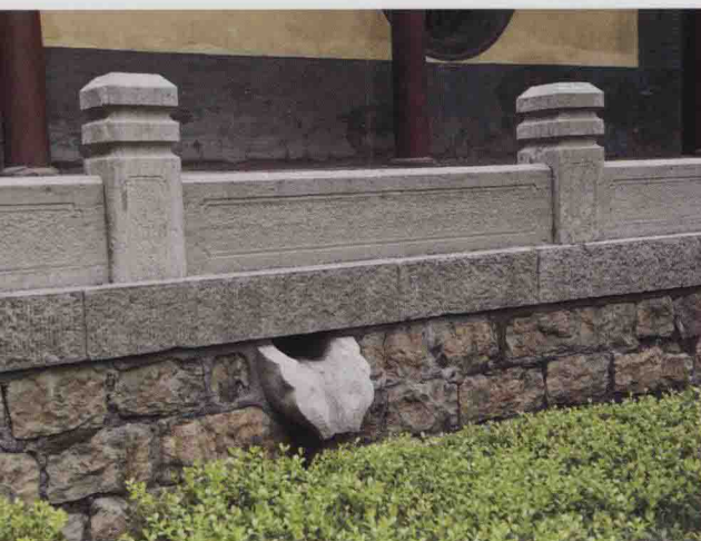
晋祠水镜台勾栏及排水口
