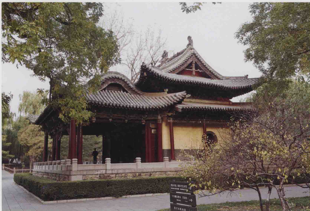
晋祠水镜台南侧立面
