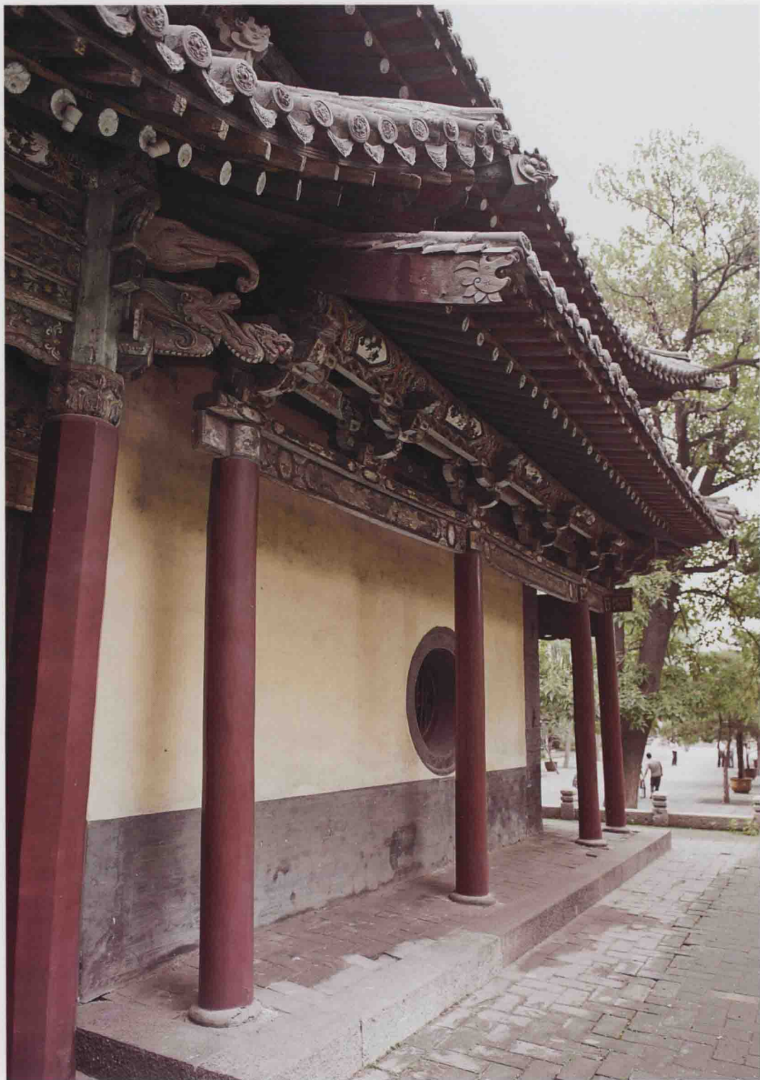
晋祠水镜台后台山面廊部
