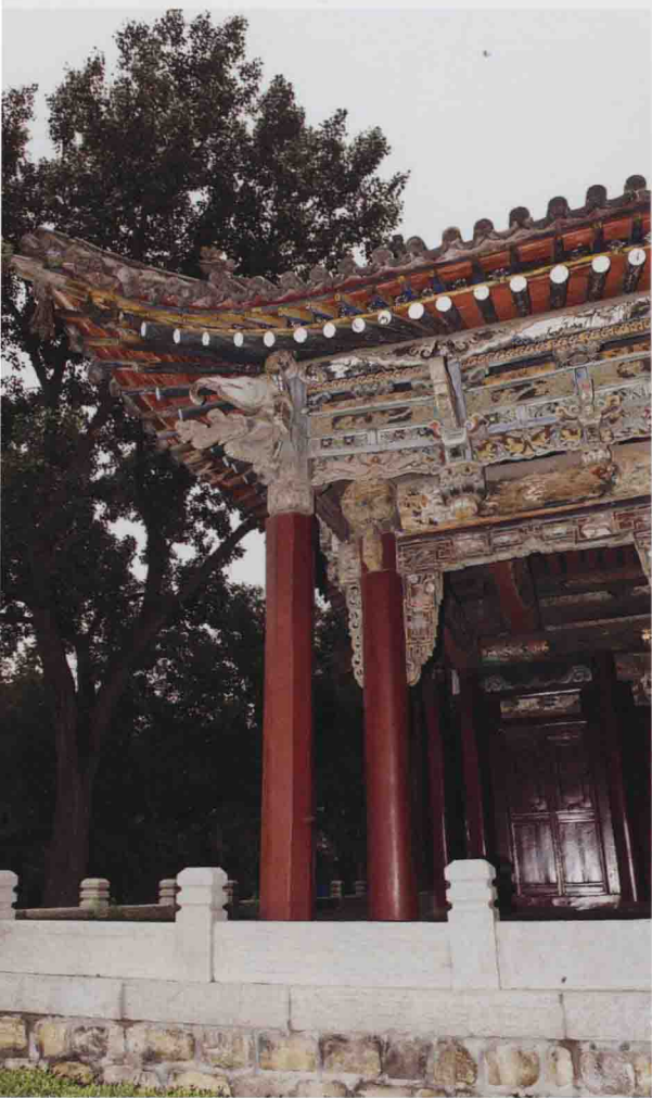
晋祠水镜台台口西北角柱及角科斗拱
