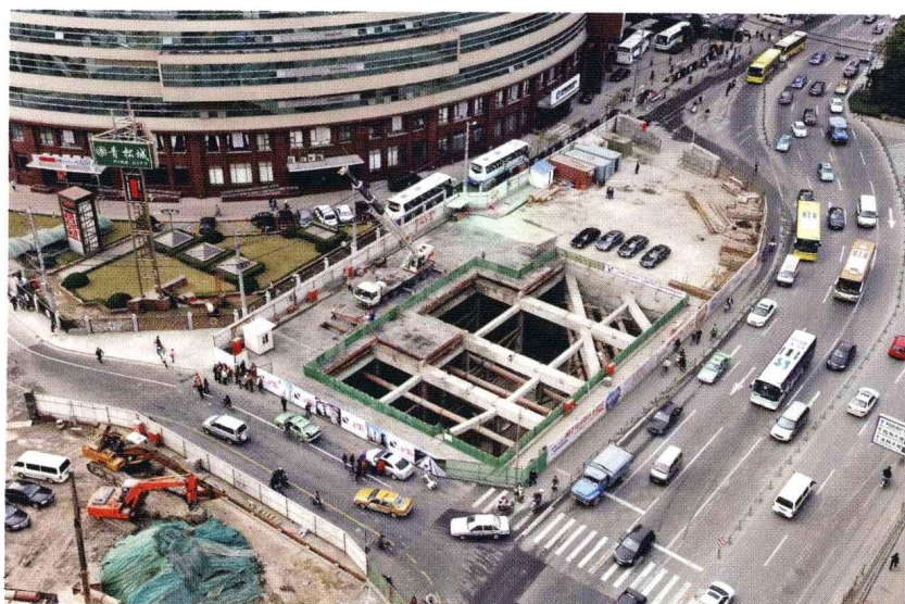
上海轨道交通7号线零陵路车站逆作法取土口
