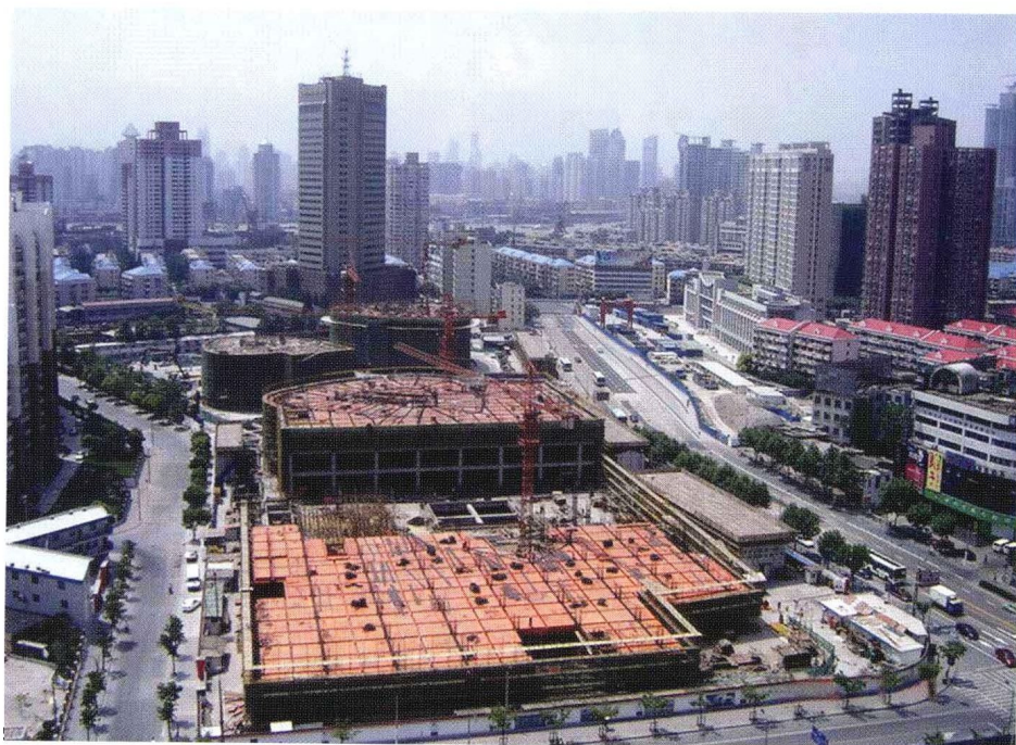
上海由由国际广场N2区顺逆同时施工实景
