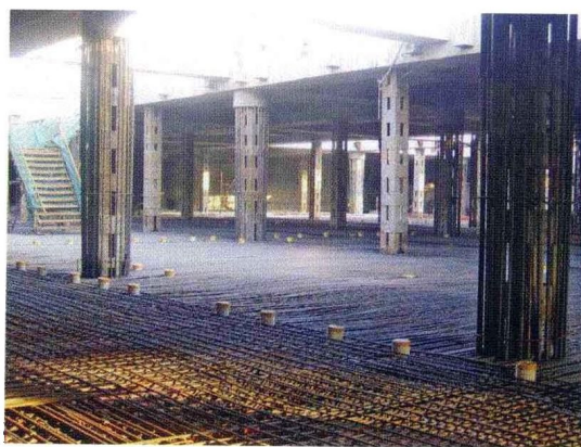
上海站北广场车库地下一层楼板施工实景
