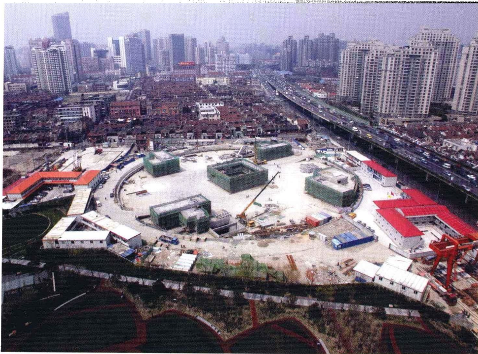
上海世博500kV输变电站逆作施工全景
