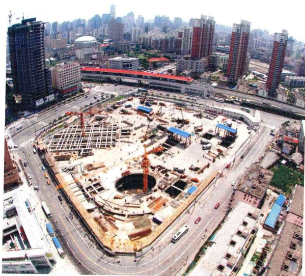
上海长峰商城逆作施工全景
