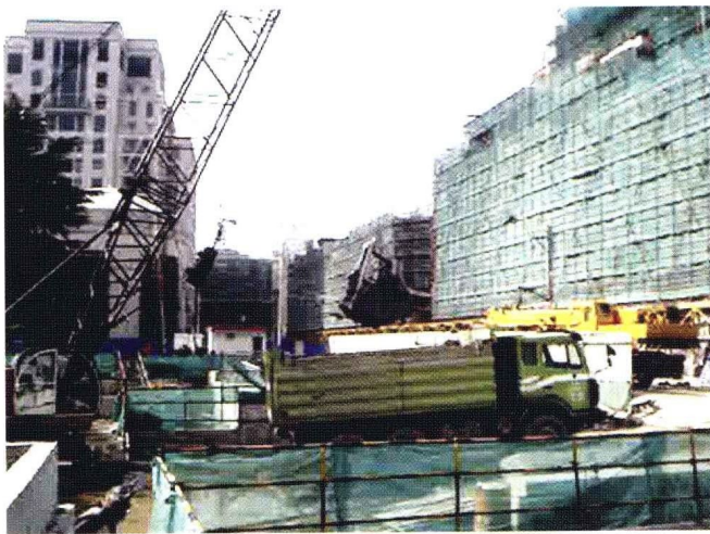
上海外滩源33号逆作法抓斗挖土
