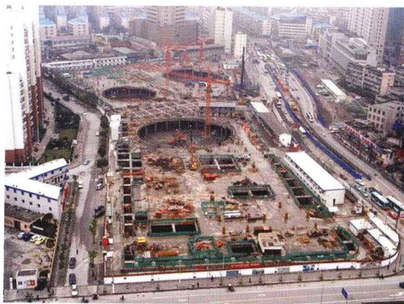
上海由由国际广场逆作阶段施工全景
