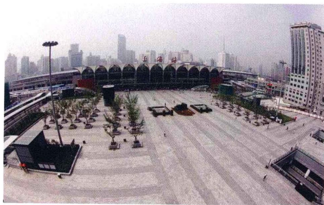
建成后的上海站北广场，其下的车库采用逆作法施工
