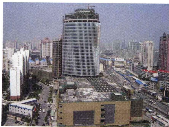
上海由由国际广场工程封顶全貌
