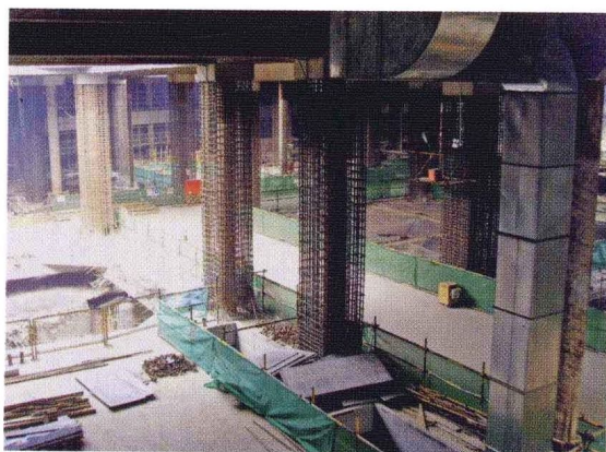
上海世博500kV输变电站地下逆作施工的实景
