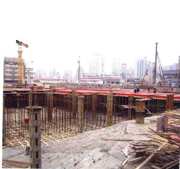
上海站北广场车库逆作顶板的模板支撑
