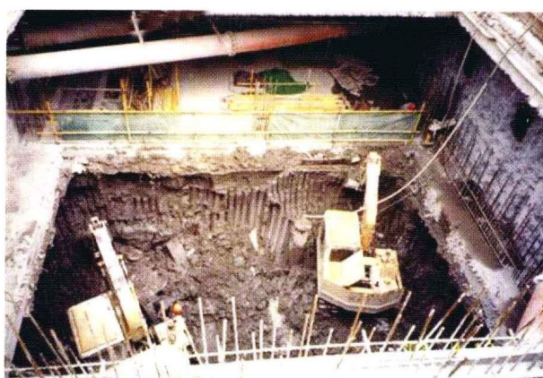
上海轨道交通7号线零陵路车站逆作土方开挖
