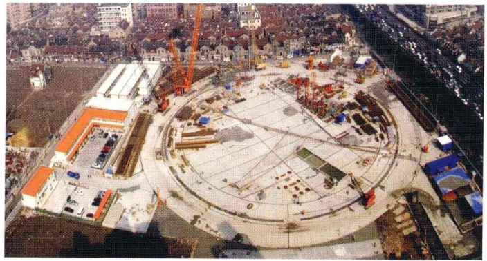
上海世博500kV输变电站地下连续墙施工全景
