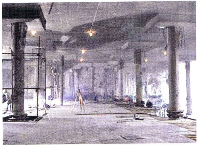
上海外滩源33号逆作法地下结构施工
