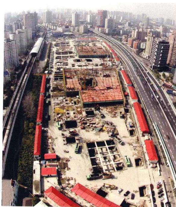
上海月星环球商业中心逆作法施工全景
