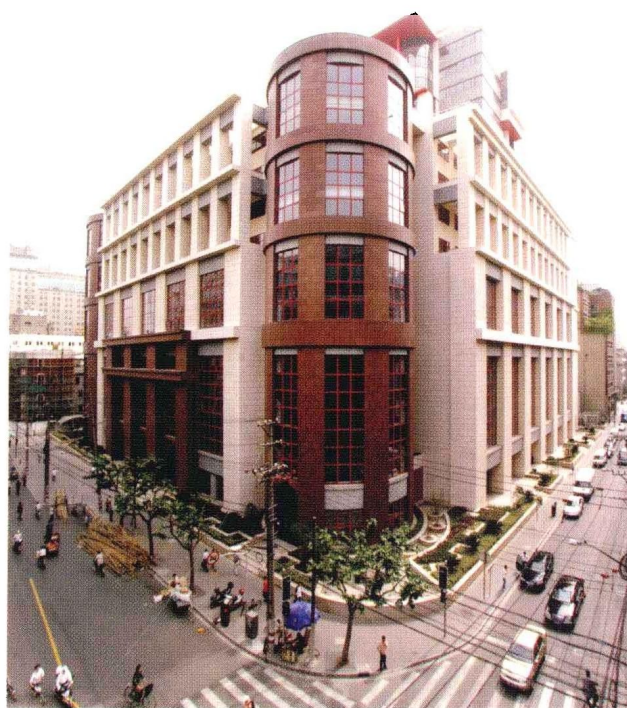
建成后的兴业银行大厦全景
