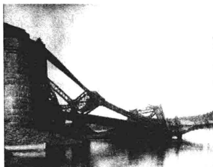
图 1-1 即将竣工时垮塌的加拿大魁北克大桥 (1907 年)
