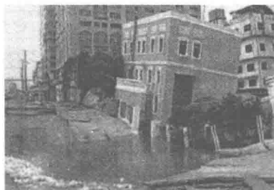
图1-3 上海地铁隧道工程事故
