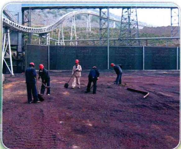
大矿工业公司工人劳动现场
