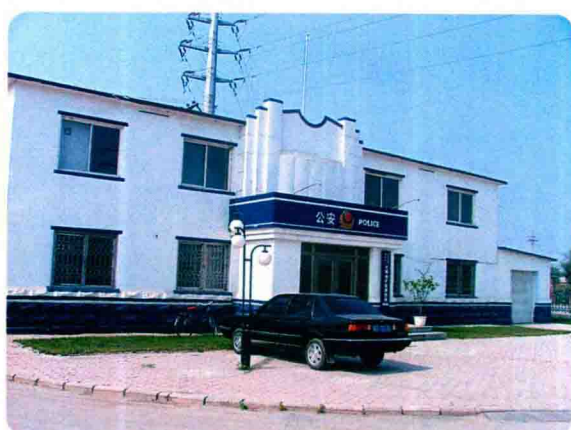
大孤山矿区派出所
