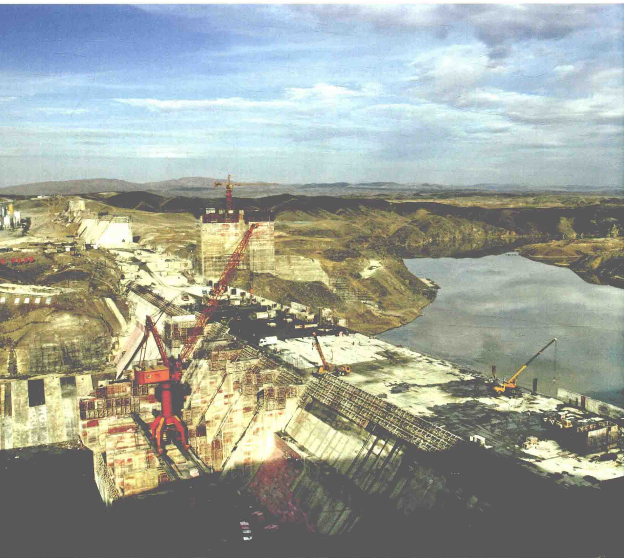
喀腊塑克水电站
