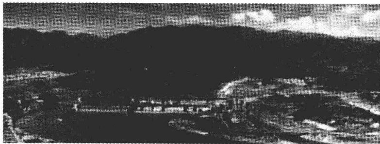
(a) 建设中的某水利枢纽工程
