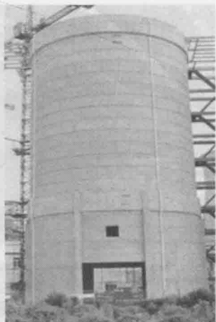
图 1-16 筒体结构建筑
