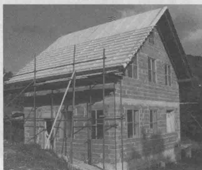
图 1-10 砖混结构建筑
