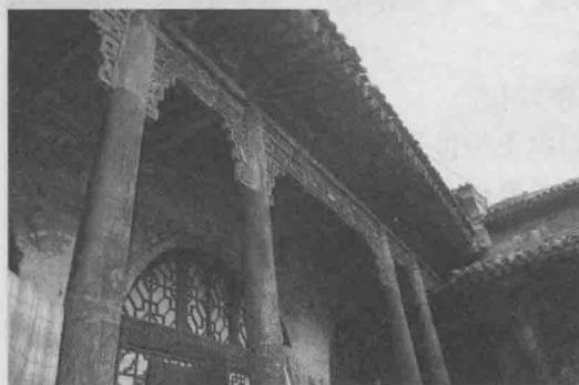
图 1-11 砖木结构建筑
