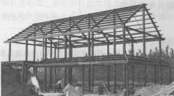
图 1-17 框架结构示意图
