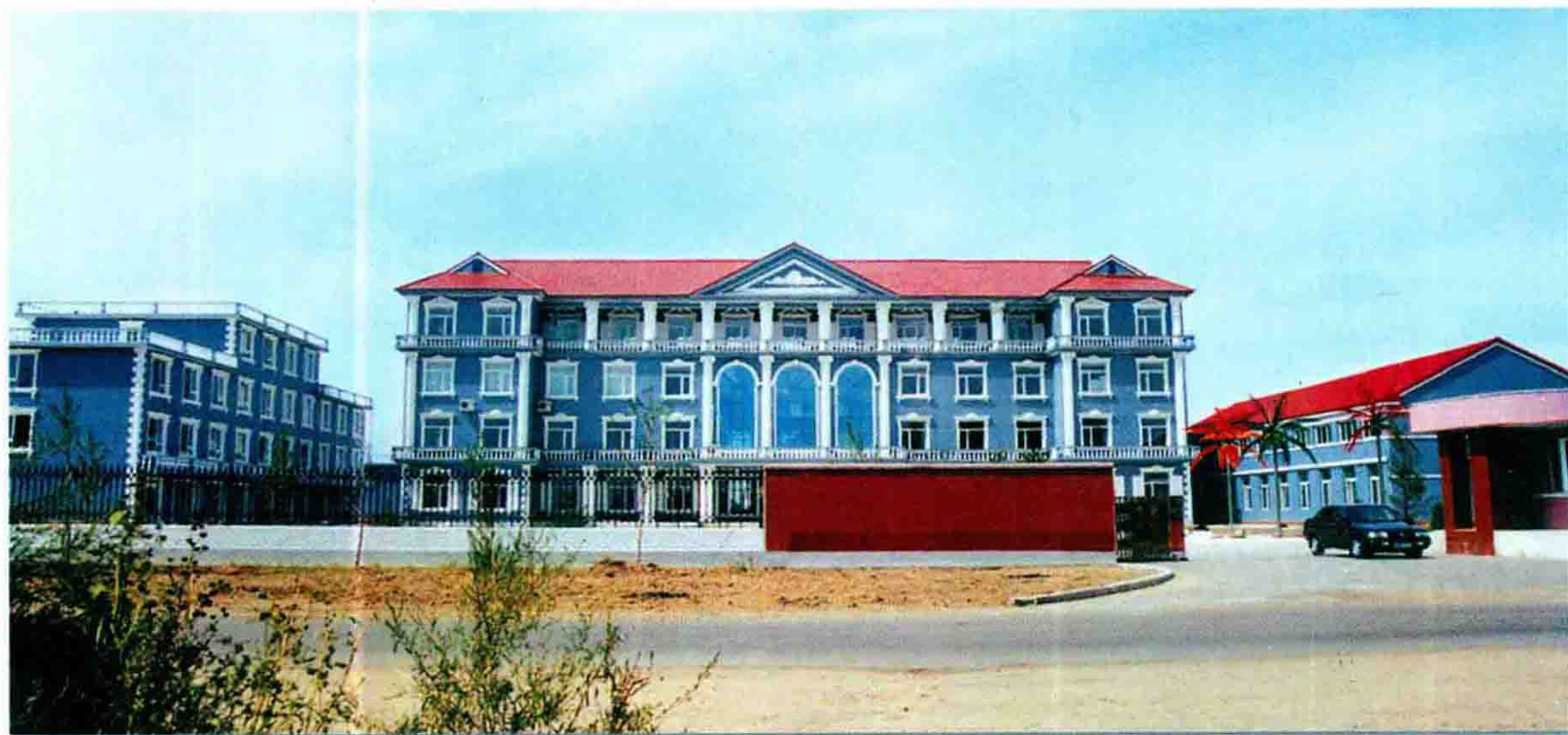
◆ 华油二厂办公楼
