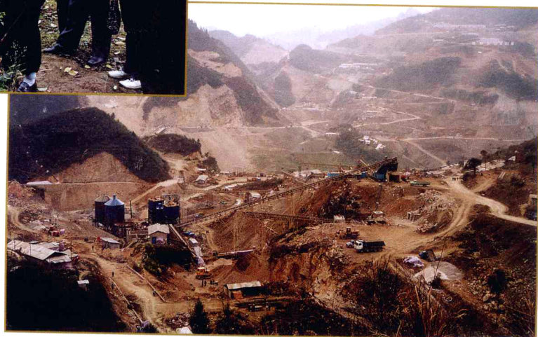
建设之中的西电东送标志性 工程——构皮滩水电站
