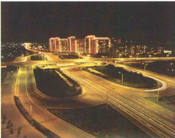
图 16 广州城市立交桥
