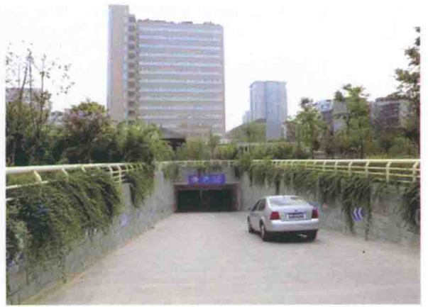
图 27 地下停车场入口
