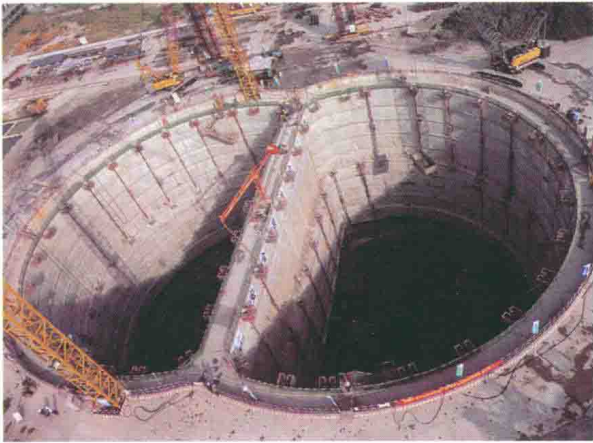
图3 地连墙施工
