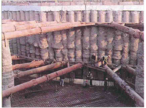
图4 深基坑支护
