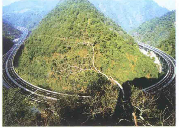
图 13 福建漳龙高速公路
