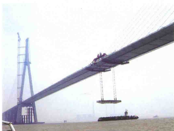
图 22 苏通大桥“合龙块”施工
