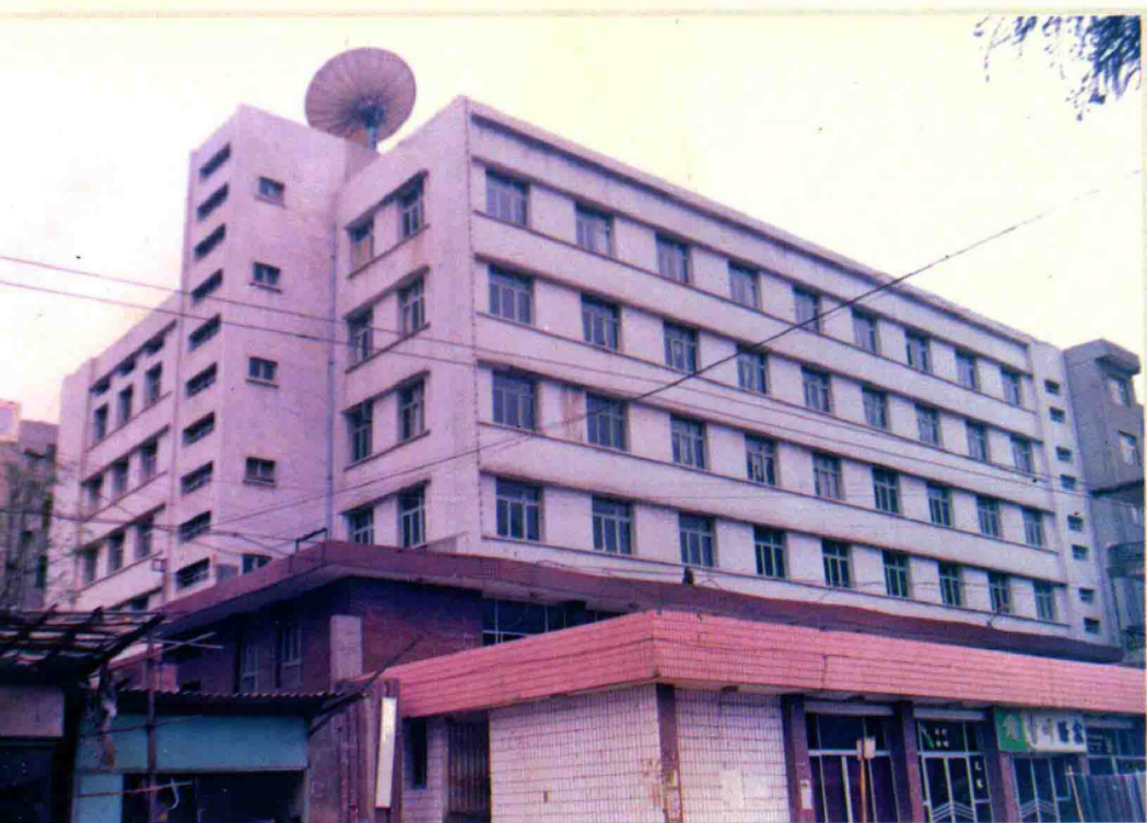
贵州省烟草公司赫章县公司办公大楼
